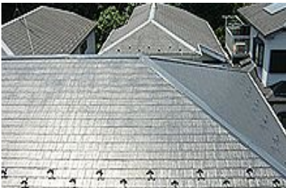
カラーベスト (スレート・コロニアル/最も多い屋根材です)
