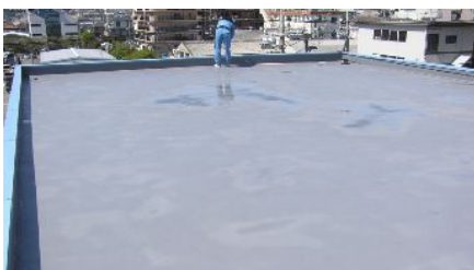
シリコン防水 (シート防水・ウレタン防水など)
