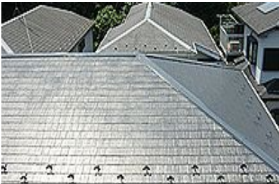
カラーベスト (スレート・コロンアル)最も多い屋根材です)
